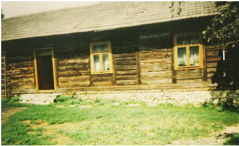
Widok od strony podwórza
