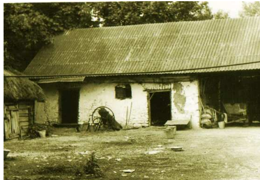
Widok na budynek gospodarczy od strony podwórza, z lewej widoczny drewniany kurnik. Stan z 1982 r.
