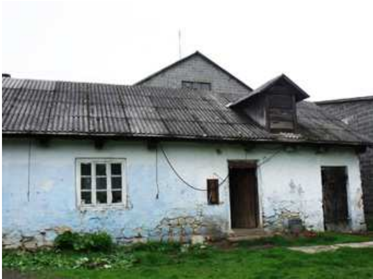
Elewacja od strony podwórza
