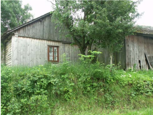
Widok od strony drogi
