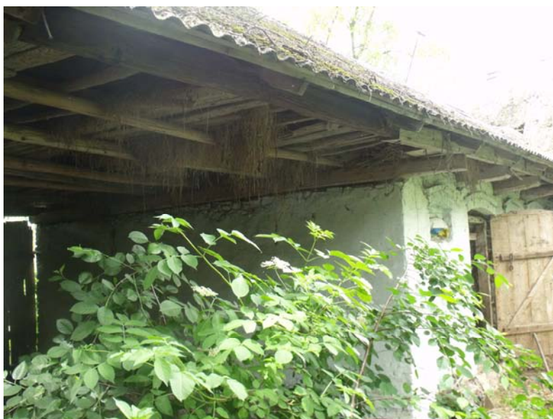
Widok na bramę przejazdową i budynek gospodarczy
