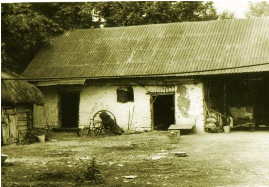
Widok na budynek gospodarczy od strony podwórza. Stan z 1982 r.
