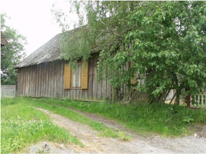
Widok od strony podwórza
