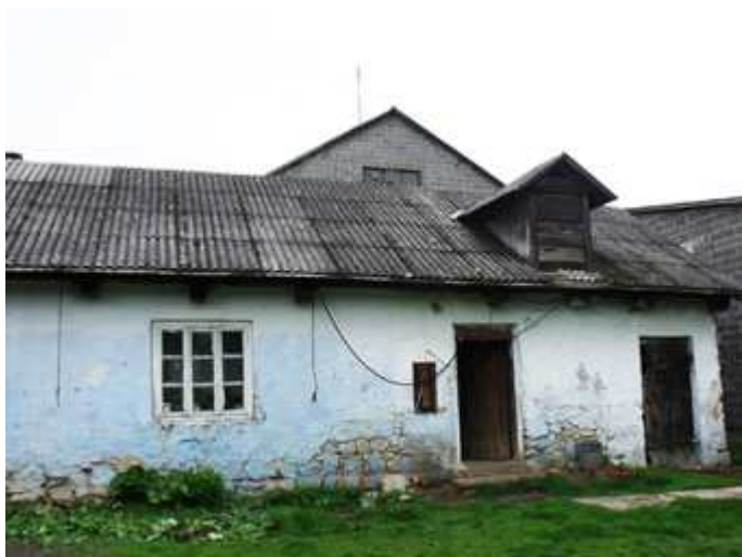
Budynek mieszkalny z częścią gospodarczą
