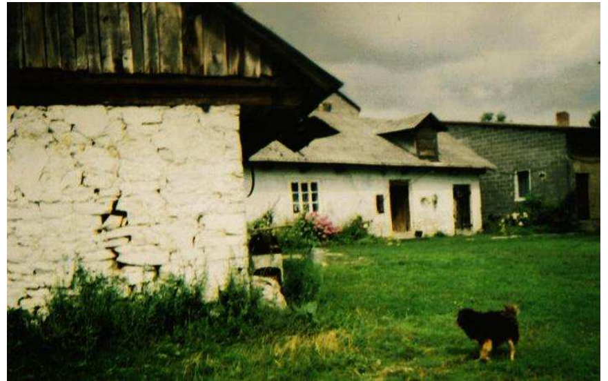
Widok ogólny od strony podwórza
