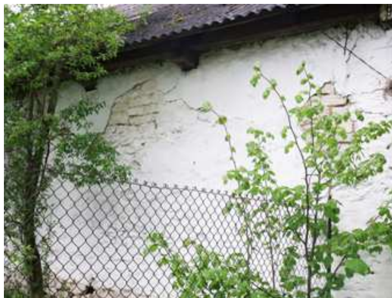
Widok na ścianę od strony drogi
